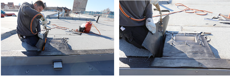
Verschweißen der Dachbahn vor Montage von Losflansch und Kiesfang.
