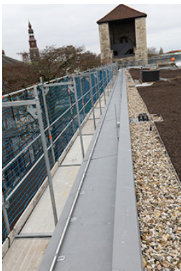
Auf Wunsch des Denkmalschutzes: Zurück gesetzte Attika, die von unten unsichtbar bleibt und die ursprüngliche Optik wahrt.
