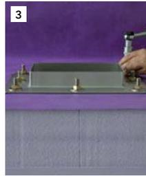
Das Dachvlies wird mit den Dichtmanschetten und dem Anstaulosflansch des SitaTurbos gemäß Herstellervorgaben eingeflanscht.
