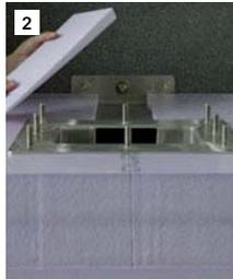
Der dreiteilige SitaTurbo Dämmkörper wird passgenau um den SitaTurbo gelegt. Bei Dämmstärken größer 160 mm können unter den Dämmkörper zusätzliche XPS Dämmplatten gelegt werden.
